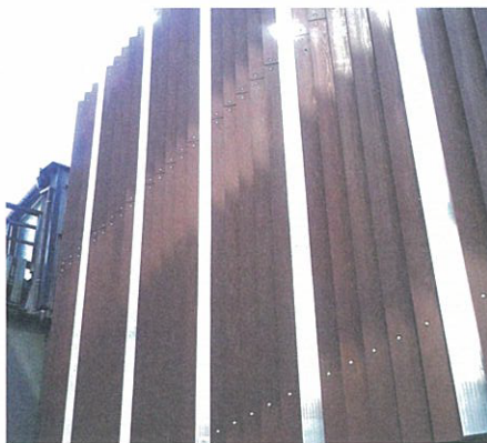
東京都・金沢ビルルーバー
