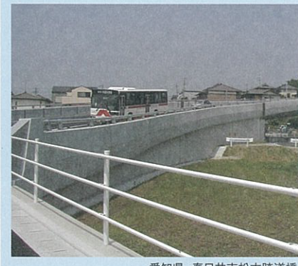
愛知県・春日井市松本跨道橋
