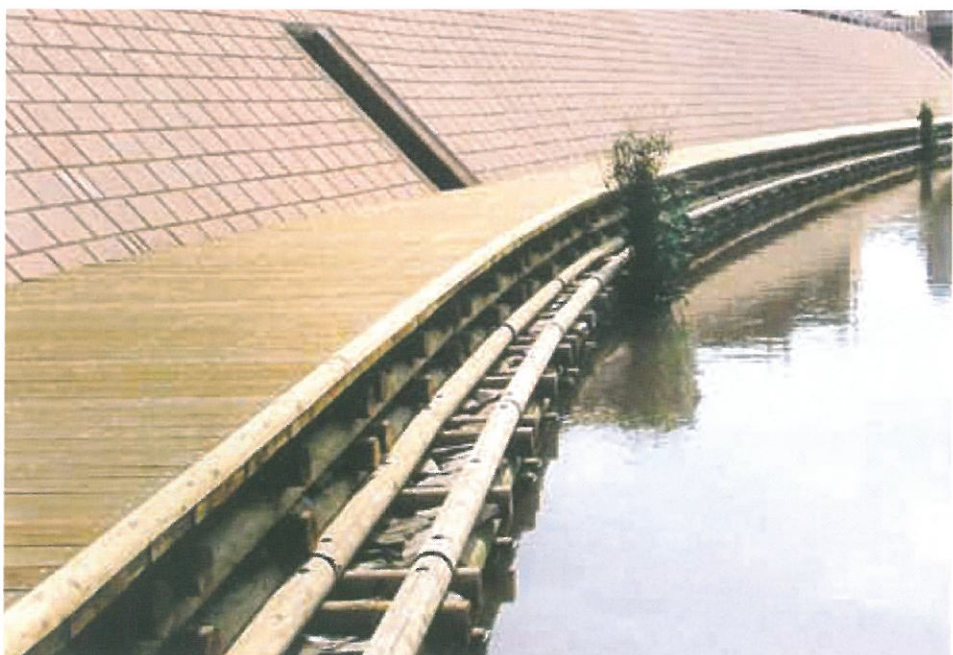
多段積 木工沈床、デッキ
