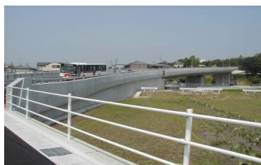
壁高欄劣化防止
