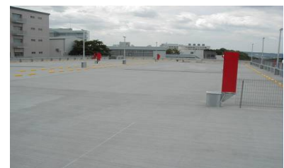
駐車場スラブ面強化（防塵）
