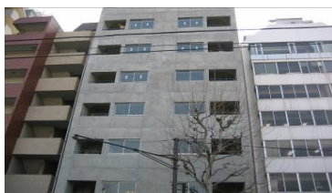
マンション外壁疎水材塗布
