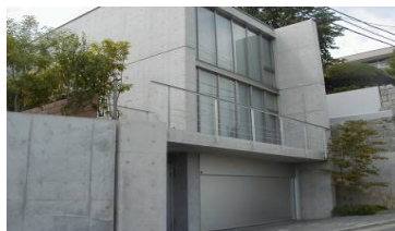
住宅外壁疎水材塗布
